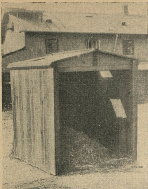
Domek z desek impregnowanych przed zapaleniem.
