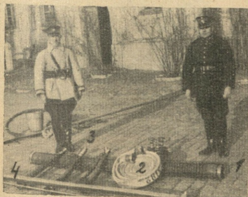
4—rura hydrantowa. 1—wąż ssący, 2—wąż tłoczny, 3—wyloty.
