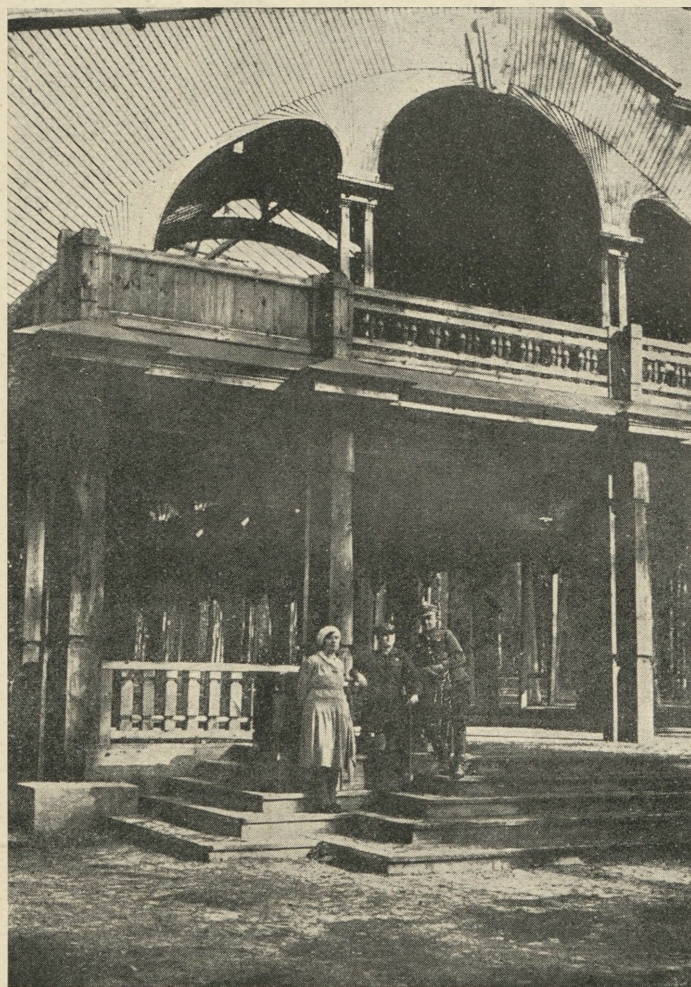
Rys. 39. Elewacja i taras.
