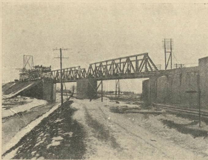
Rys. 1. Montaż przeciwwagi i widok mostu drugiego toru.
