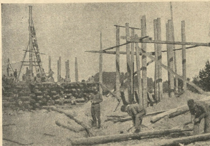
Rys. 71. Stężenie przyczółka (lewego).
