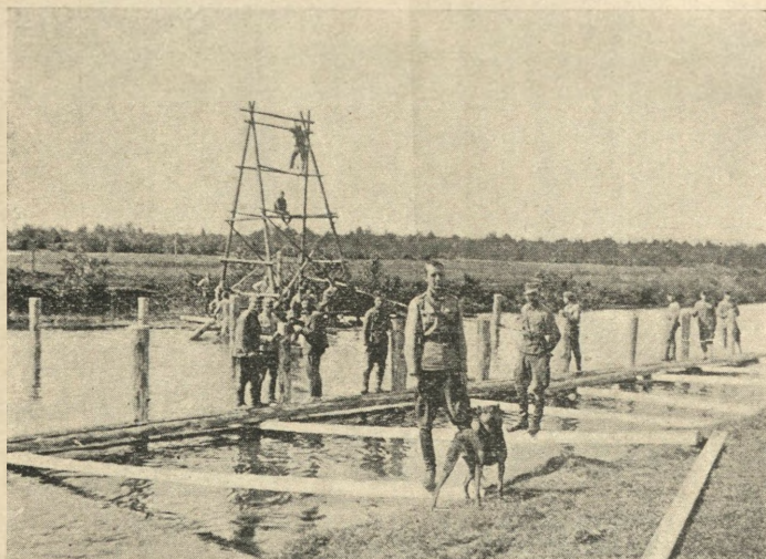
Rys. 10. Bicie pali kafarem polowym pod rusztowanie.
