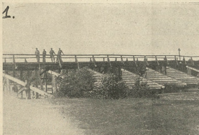
Rys. 41. Widok od strony izbic.
