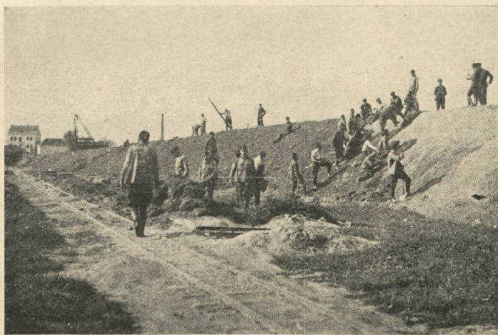
Rys. 86. Darninowanie skarp nasypu.
