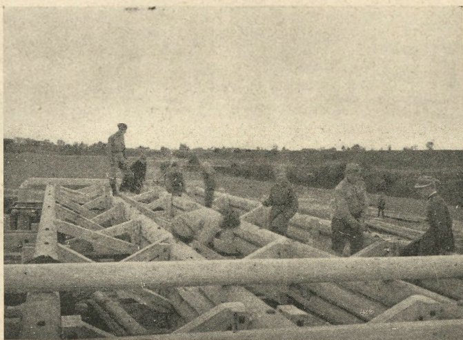
Rys. 31. Stężanie dźwigarów.
