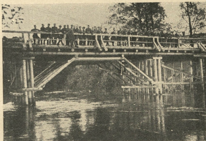
Rys. 94. Przęsło zastrzałowo-trapezowe.
