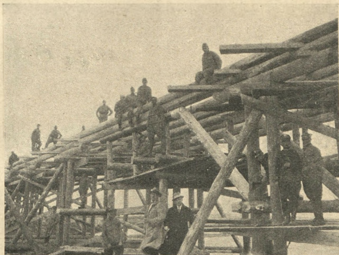
Rys. 18. Mikołajewszczyzna: montaż przęsła rozporowego (5 p. sap.).
