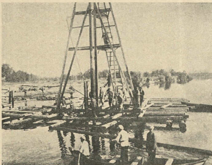
Rys. 70. Kufar parowy na rusztowaniu.
