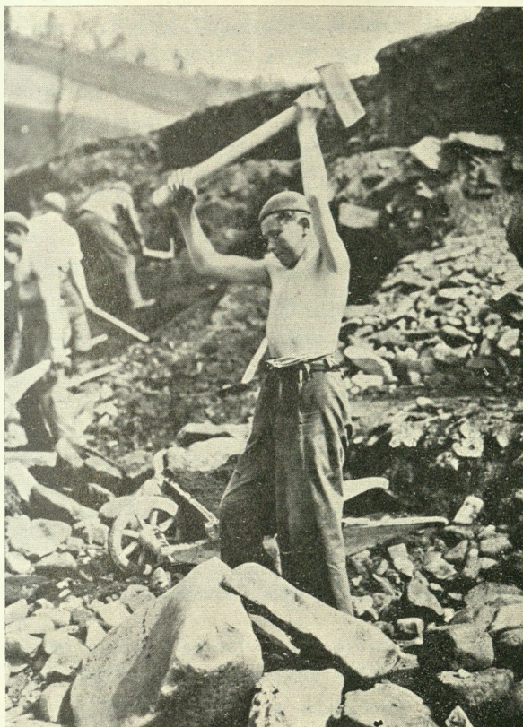
Ryc. 4 Prace przy budowie drogi na Równicę
