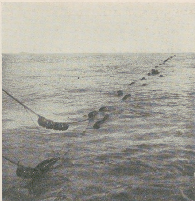
20. Ausbringen eines englischen U=Boot=Netzes Das Netz wird von Tausenden von wassergrünen Glasfugeln, die vom U=Boot aus schwer sichtbar sind, getragen
