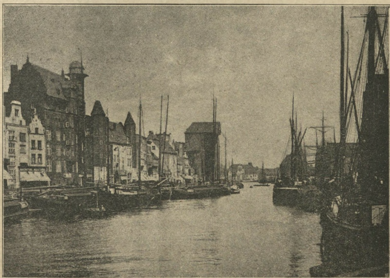
Rys. 72. Port w Gdańsku nad Motławą.
