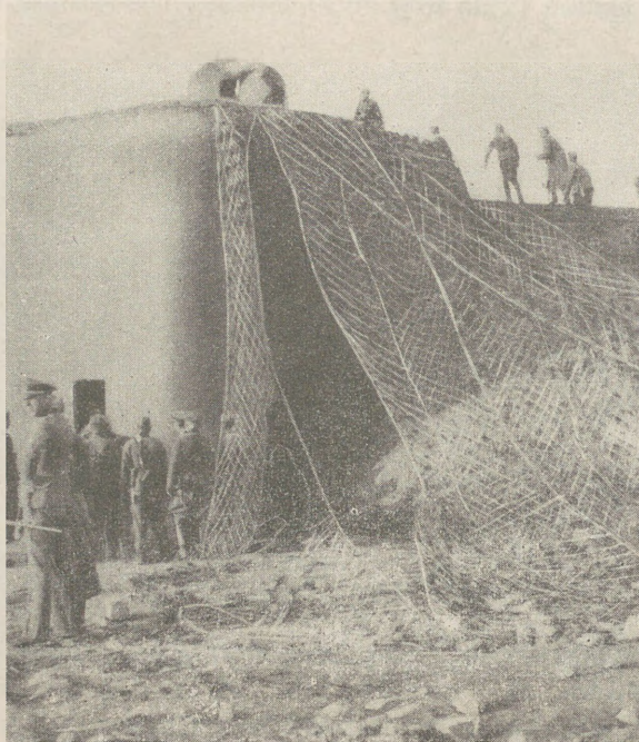
Bild 171 Begonnene Tarnung eines größeren Werkes
