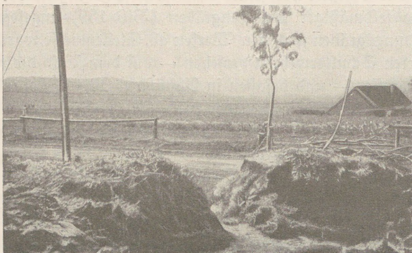
Bild 191 Schützenstand, einfache Erdschüttung
