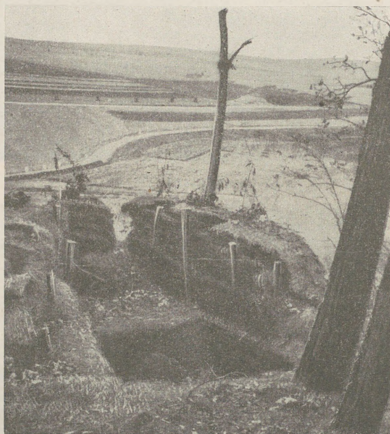
Bild 192 Schützenstand oder M. G.-Stellung, Steinaufwurf überdeckt mit Erdziegeln
