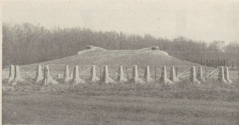
Bild 138 Sperre aus Eisenbetonigeln. Rechts im Hintergrund des Bildes eingerammte Schienen, deren Zweck bei Bild 150 erklärt wird
