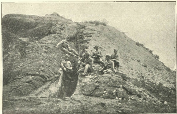
BUDOWA REZERWY OKOPÓW POD KONARAMI.
