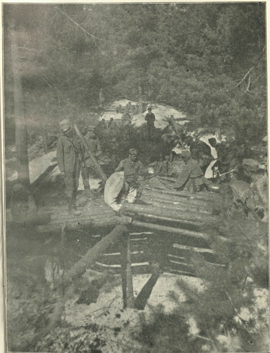
PRZY BUDOWIE ZIEMIANEK.
