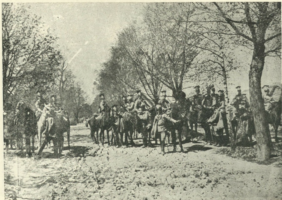
KAWALERZYŚCI I. BRYGADY W ZAGAJU.
