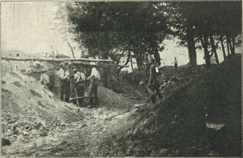
BUDOWA OKOPÓW W DZIERŻKOWICACH.
