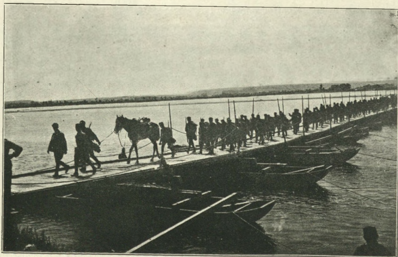
PRZEJŚCIE PRZEZ WIEPRZ.
