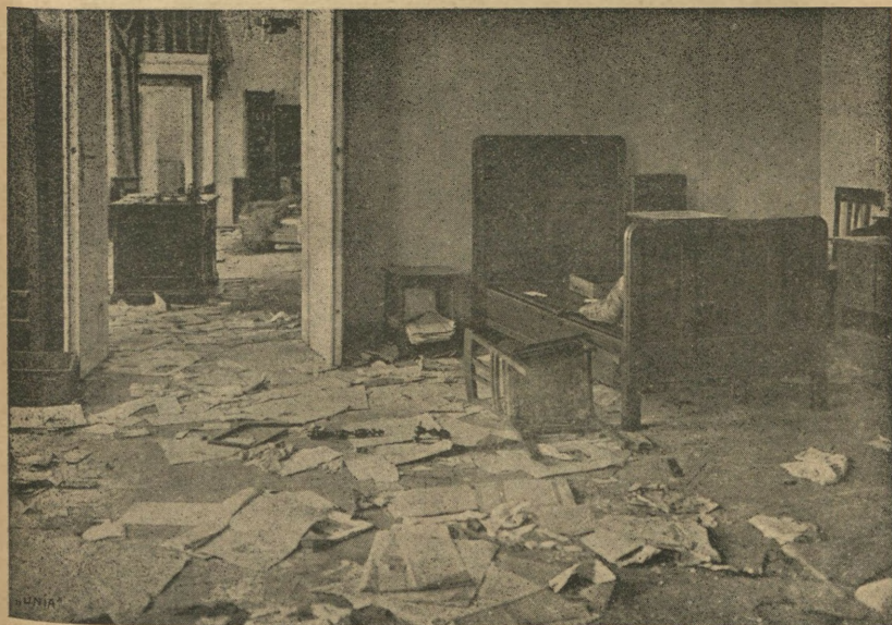
Mieszkanie pryw. dyr. Rein'ändera, zniszczone przez Ukraińców.
