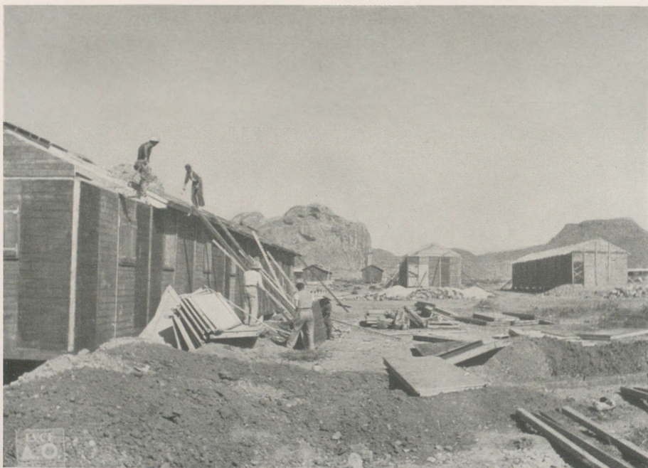
Errichtung von Arbeiter-Baracken
