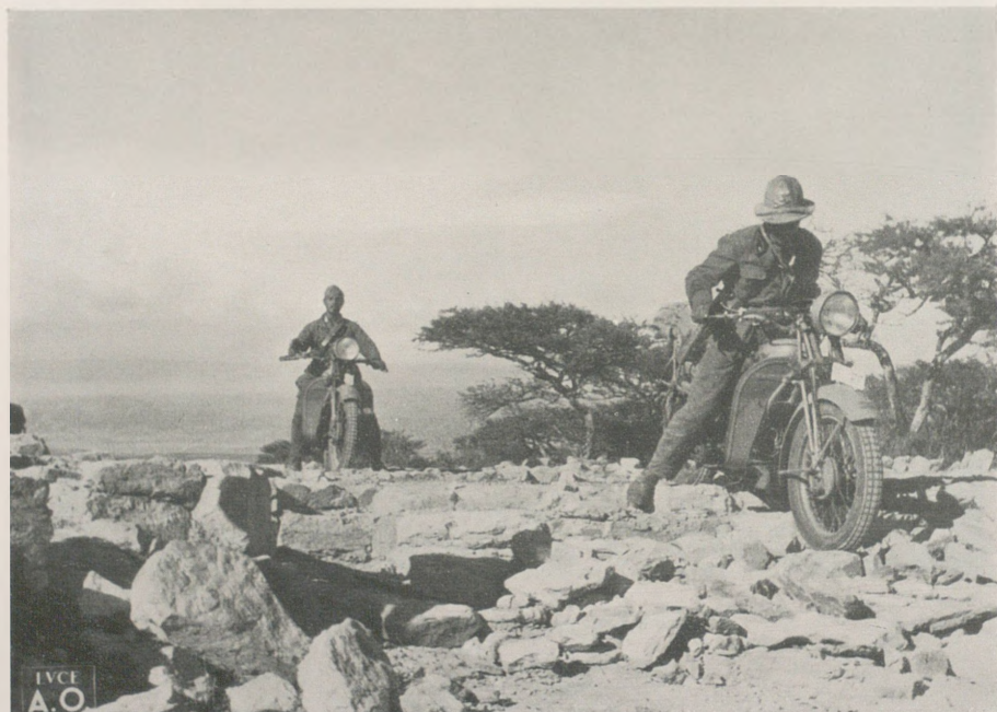
Motorradfahrer im Dienst auf den im Bau befindlichen Straßen
