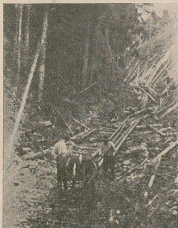
Ryc. 23. Pidwołoki, po których przesuwają „od schodu do schodu“ pnie drzewa, po spuszczeniu ich ze stoków bezpośrednio lub ryzami, Zielona-Komarnyky (za Sitnykiem, czyli bliżej Zieleniczki).
