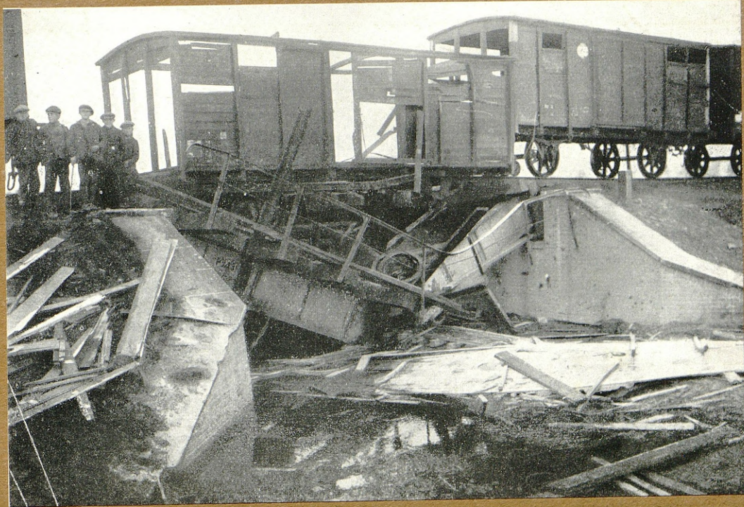
MOST KOLEJOWY POD BRWINOWEM, WYSADZONY PRZEZ NIEMCÓW.
