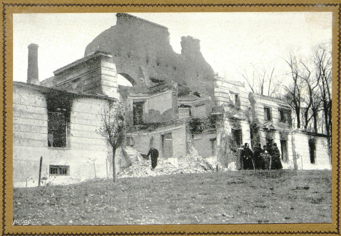
FRAGMENT DWORU W PĘCICACH WIELKICH POD WARSZAWĄ.
