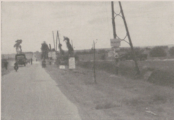
Wszystkie drogi pełne są wozów wiozących zaopatrzenie. Just behind the front line the roads are packed with the supply lorries.
