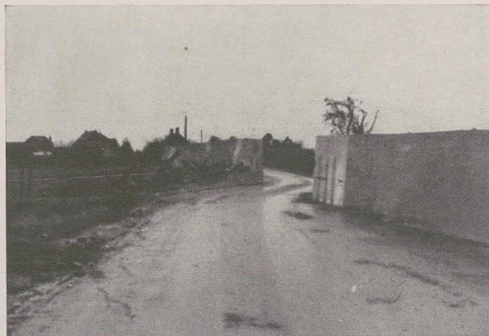
Barykady na szosie pod Moerdijk. Barricades on the road to Moerdijk.
