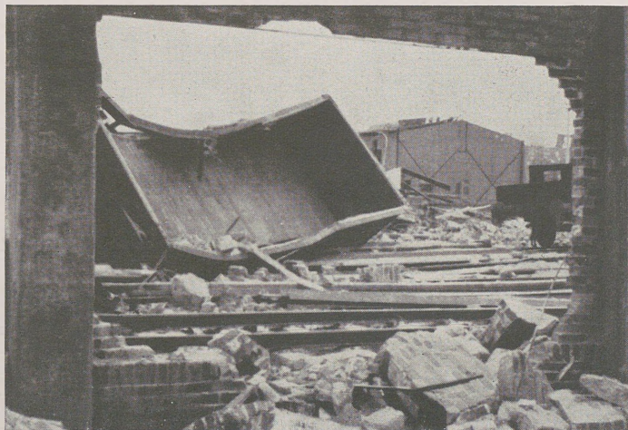
Zniszczone tory kolejowe. Destroyed rail-tracks.
