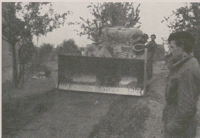
Buldozer przygotowuje stanowiska dla czołgów. New tank positions are being prepared.
