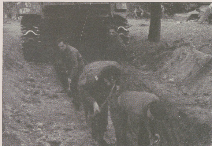
Załoga przy budowie „domu”. Tank crews are digging in.
