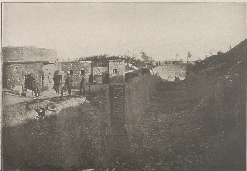
Graben der Südfront mit Zerstörungen durch 28- und 30,5 cm-Granaten.
