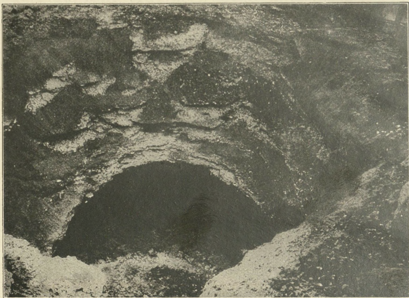
Fort Wavre-Ste. Catherine Betondecke der Kaserne, durchschlagen von einem 42-cm-GeschöÙ
