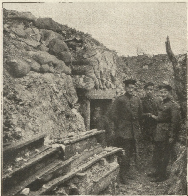
Notdürftig ausgebesserter Stolleneingang im zertrommelten Graben.
