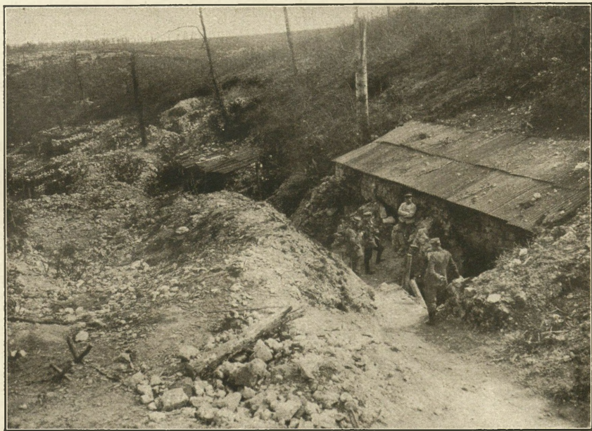
Unterstände in den Argonnen.
