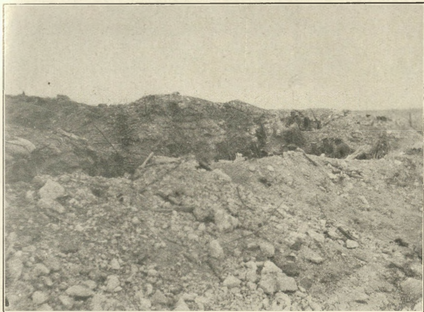
Fort Bang, Ausgang des westlichen Hohlgausses nach dem Fortthof.
