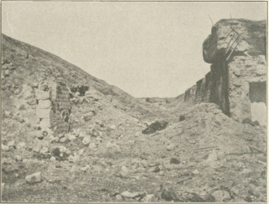
Fort Vaux, Frontgraben. vorn rechts Teil der Grabenstreiche der Nordostecke. Im Hintergrunde, in der Verlängerung des Grabens, die Grabenstreiche der Norddecke.
