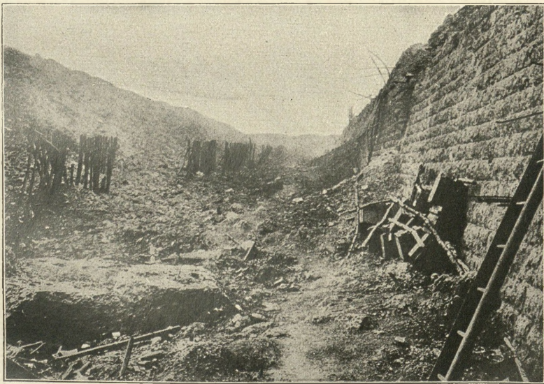
Graben der Westfront mit zerstörtem Hindernisgitter.
