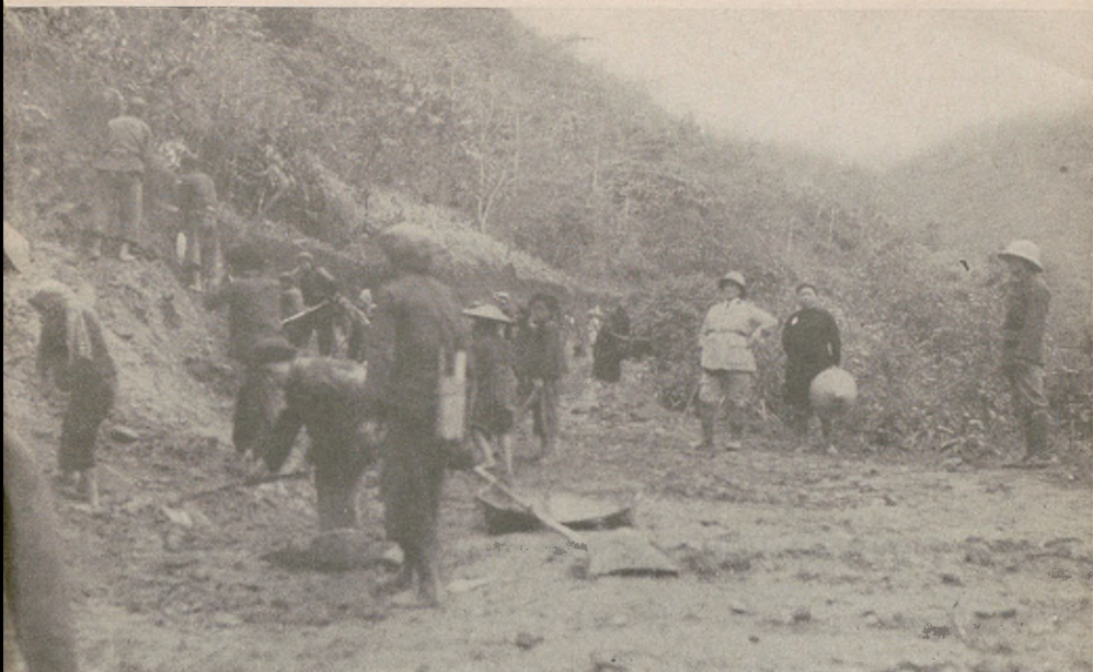
Travaux de construction de la route Tinh-Tuc Bao Lac.
