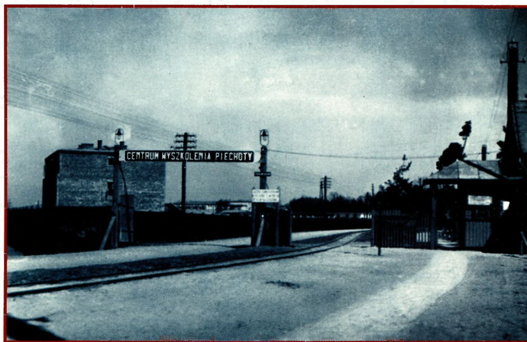
Brama CWPiech (początek lat trzydziestych)
