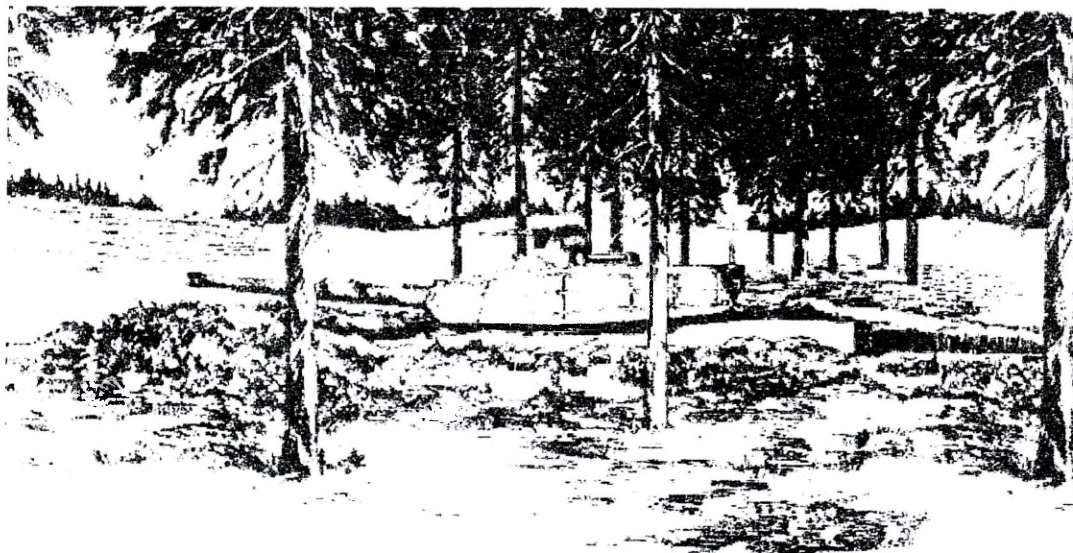
Rys. 5. Okop dla czołgu zbudowany w terenie lesistym
