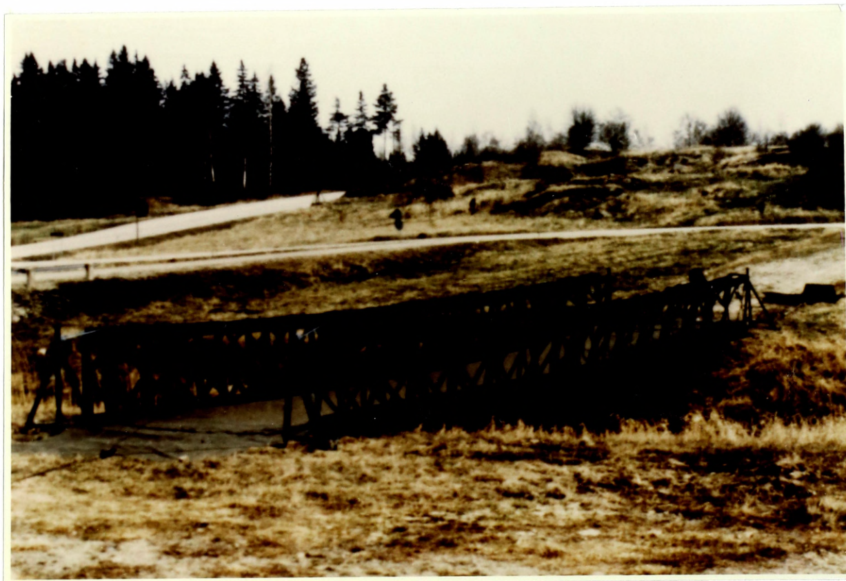
Fot.14. Makieta mostu składanego typu "BAILEY"
