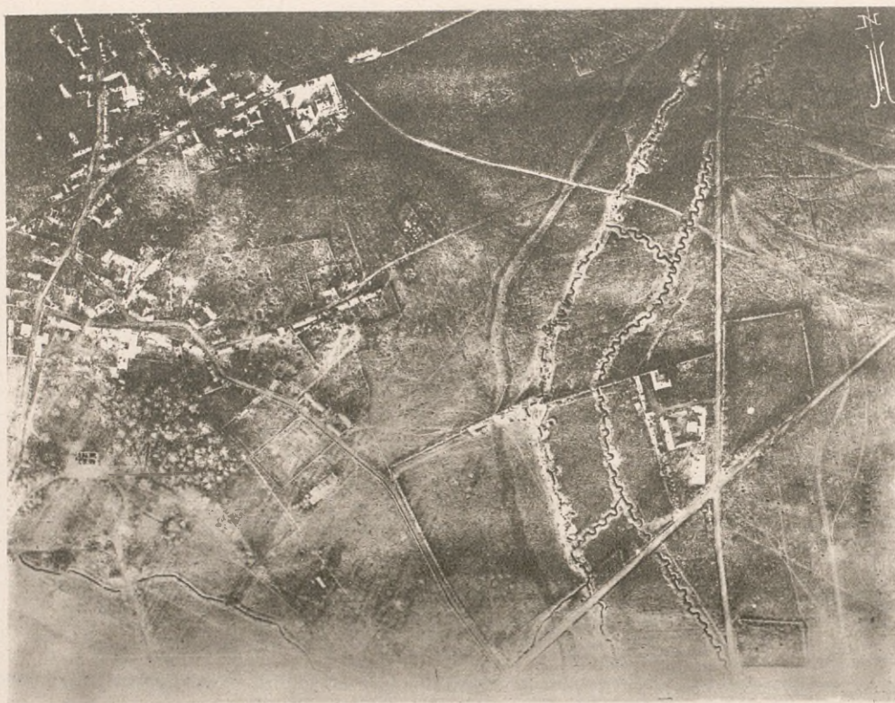
Fot. Nr. 333. Okopy pod Misery.
