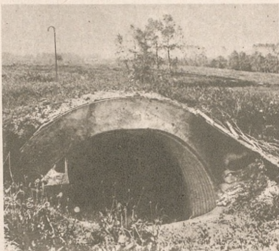
Fot. Nr. 266. Schron działowy betonowy.
