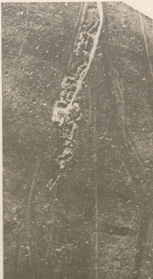
Nr. 88 a. Ta sama bateria dnia 17.11.17. wykończona i zamaskowana (wys. 2600 m. F. = 50).
