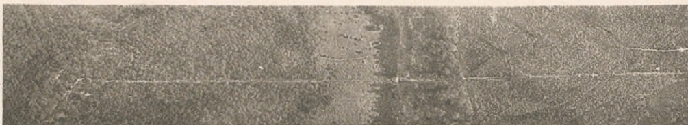
Fot. Nr. 126. Kolejka linowa. Widać słupy. (Rej Vosges, W. 3100 m. F = 50 cm.).
