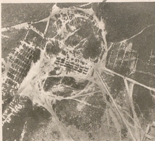
Fot. Nr. 178. Baraki rezerw. 86 baraków 4 x 14 m.
