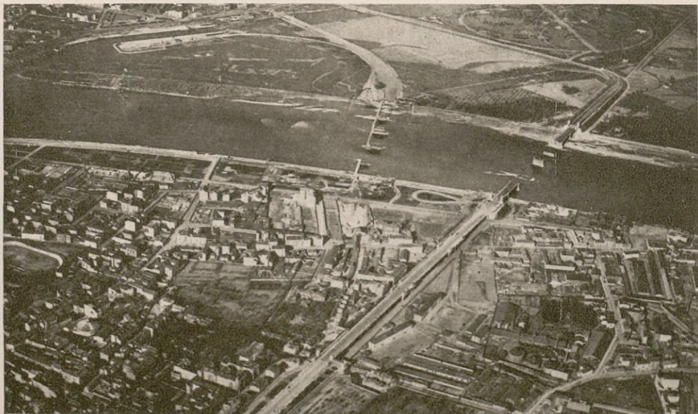
Fot. Nr. 131. Zniszczony most żelazobetonowy. Na lewo most kolejowy w budowie. Obok filarów kładka dla robotników. (Wys. 600 m. F = 26).
