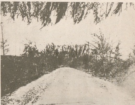
Fot. Nr. 61. Takież zastłony, utworzone z gałęzi, zawieszonych na drutach.
