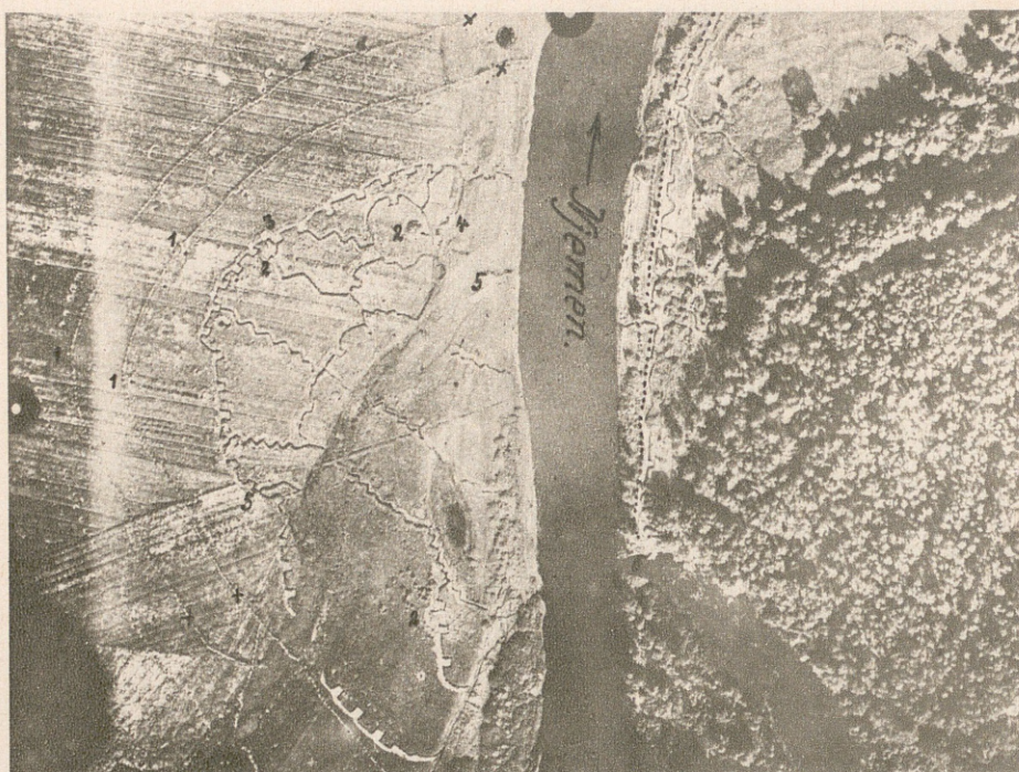
Fot. Nr. 12. Przyczółek mostowy na rz. Niemen. 1 — przeszkody z kozłów hiszp., — przejścia oznaczone krzyżykami, 2 — schrony, 3 — stan. K. M., 4 — schron w budowie, 5 — materiał budowlany, 6 — łodzie.
