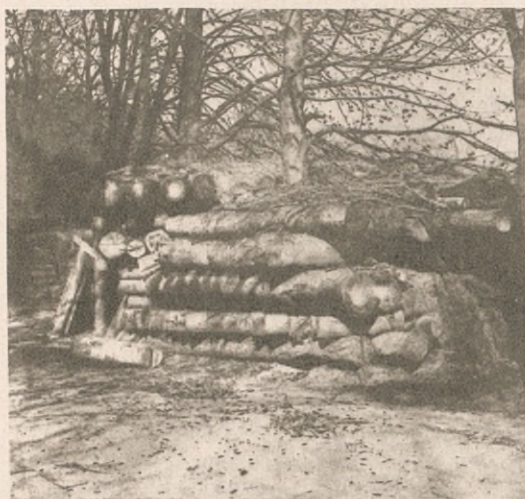
Fot. Nr. 265. Schron działowy z belek drewnianych.
