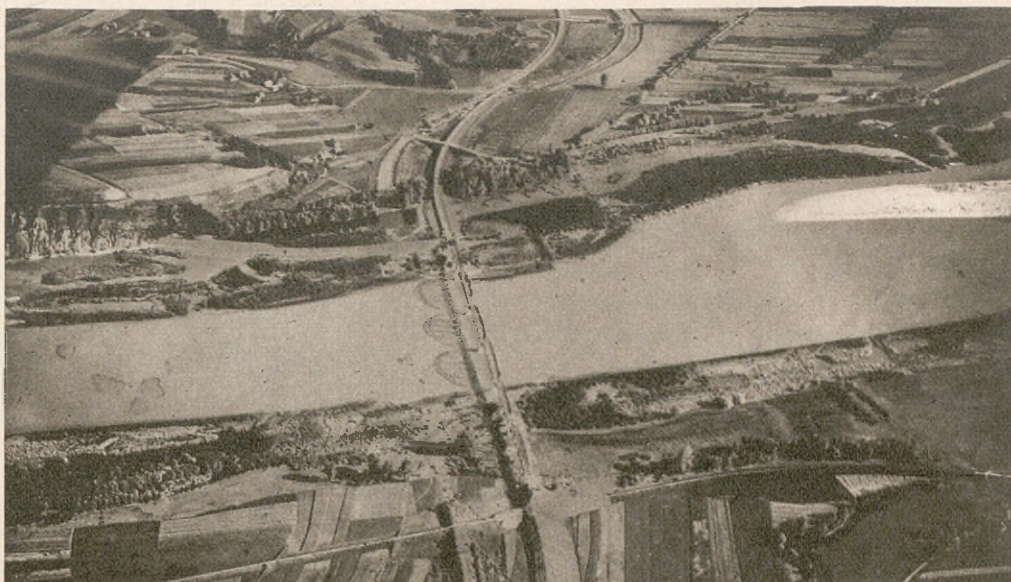
Fot. Nr. 128. Most kolejowy żelazny. Cień wskazuje konstrukcję mostu. (Wys. 500 m.)
