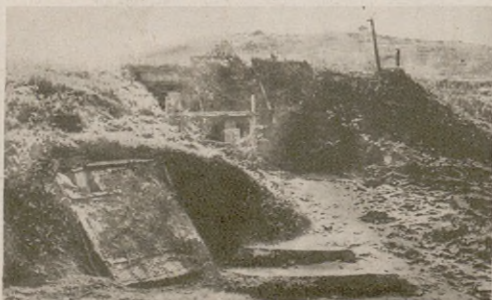
Fot. Nr. 71. Dział, okryte darnią; wyloty dział zakryte siatkami.
