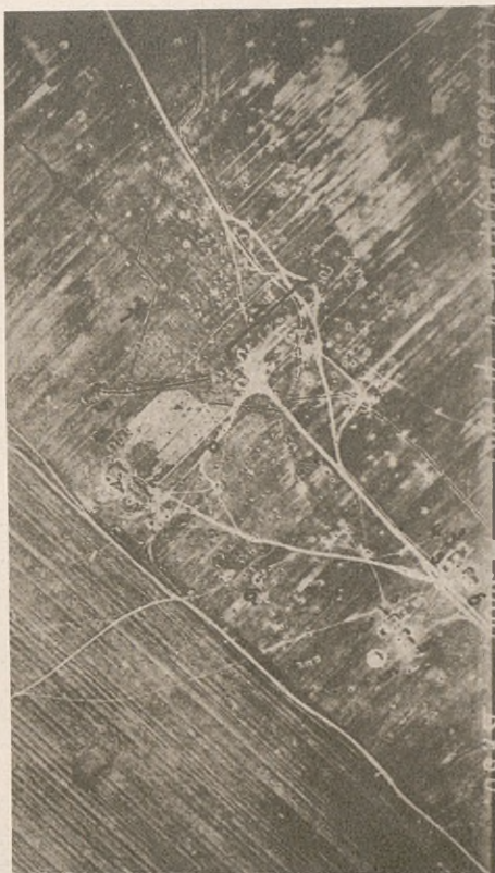
Fot. Nr. 278 Stanowisko baterji ros. na terenie odkrytym, dobrze widoczne dzięki drogom. Bateria (1), po ostrzeżeniu przeniosła się na stan. rezerwowe (3). Schrony dla obsługi, przed schronami ogródki (2), nowe schrony betonowe (4, 5), schron w budowie (6), rów z kablem telefonicznym (7). Wys. 3000 m., F=50.
