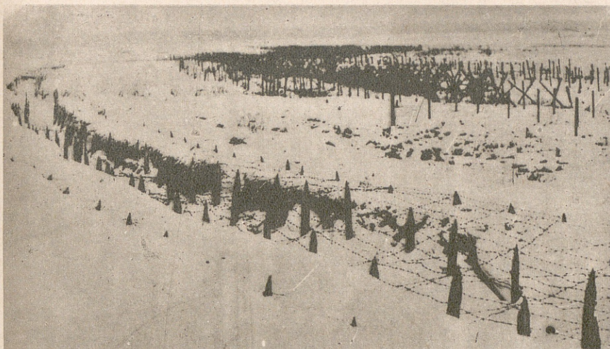
Fot. Nr. 219. Druły kolczaste zasypane śnie- giem na odcinku Legzda - Nejn.
