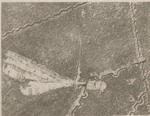
Fot. Nr. 93. Budowa tunelu, zdradzona przez wyrzuconą ziemię. (Mort Homme, W. 3000 m. F=50).
