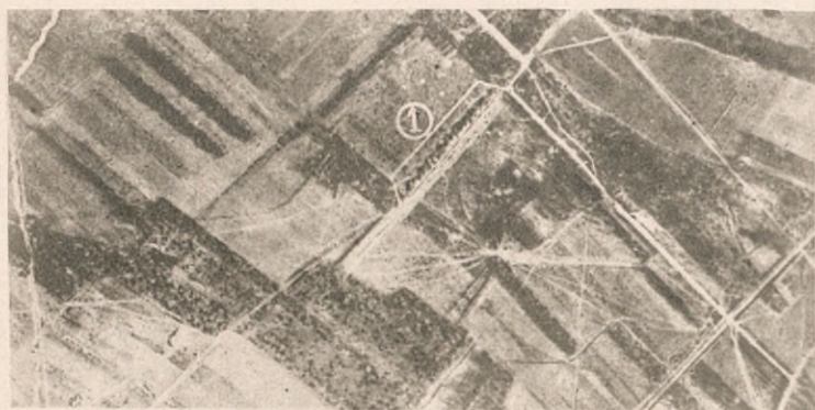
Fot. Nr. 327. Bateria w schronach nieostrze- lana.
