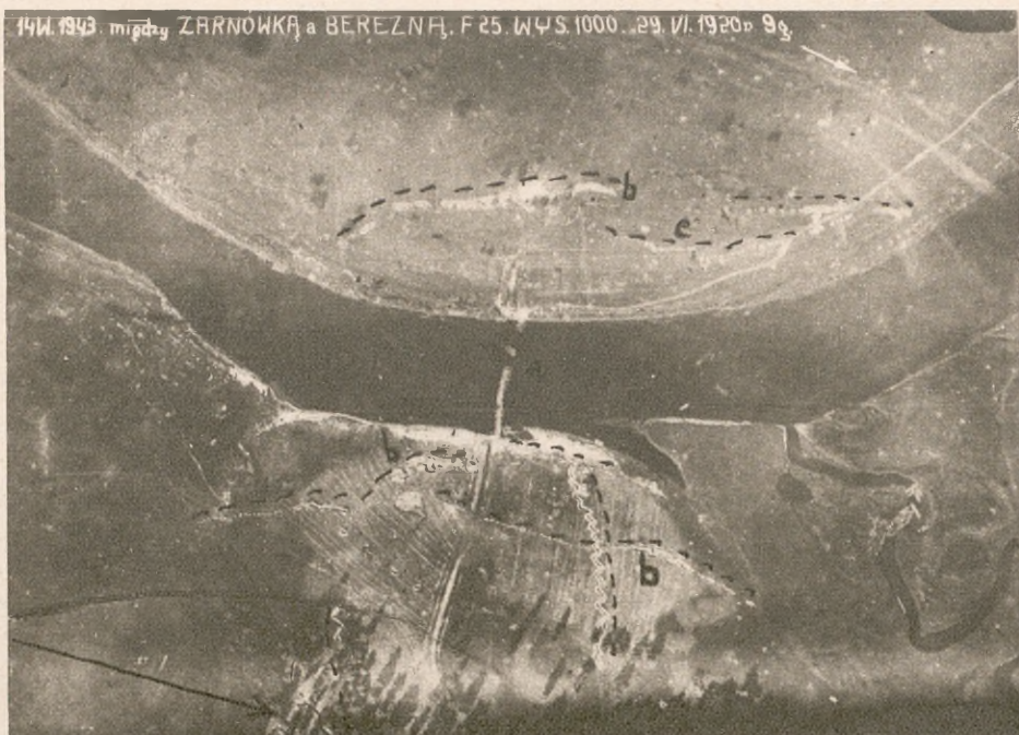
Fot. Nr. 43. Przykład opisanego zdjęcia. Most jarzmowy w budowie (a), okopy w budowie (b), wnęki strzeleckie (c).
