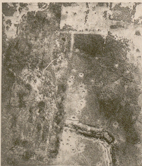
Fot. Nr. 230. Schron betonowy dla gniazda K. M. Wys. 1500 m., F=50cm (Flandria).
