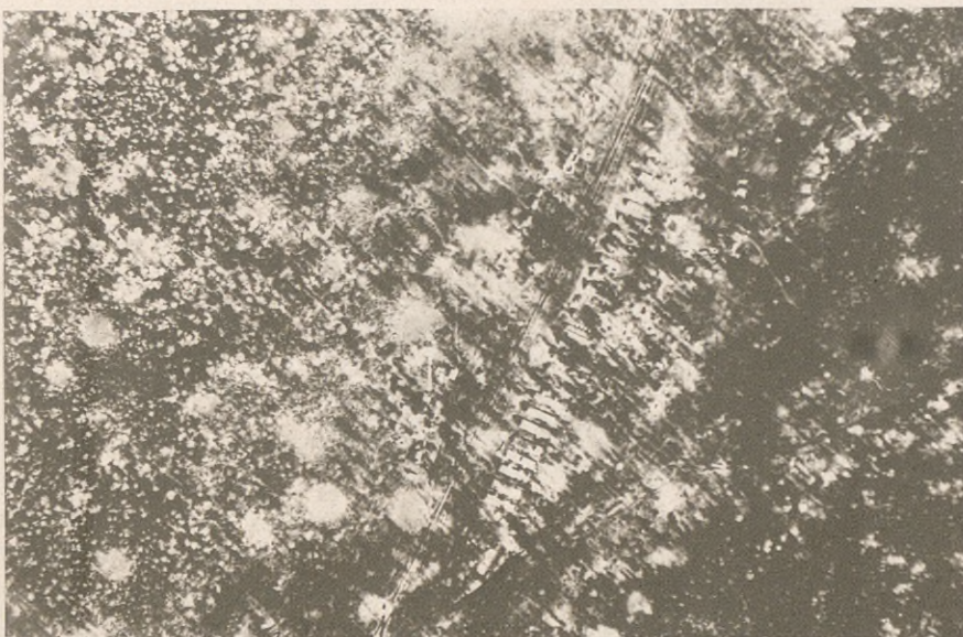
Fot. Nr. 78c. Baraki wykończone i częściowo zamaskowane
