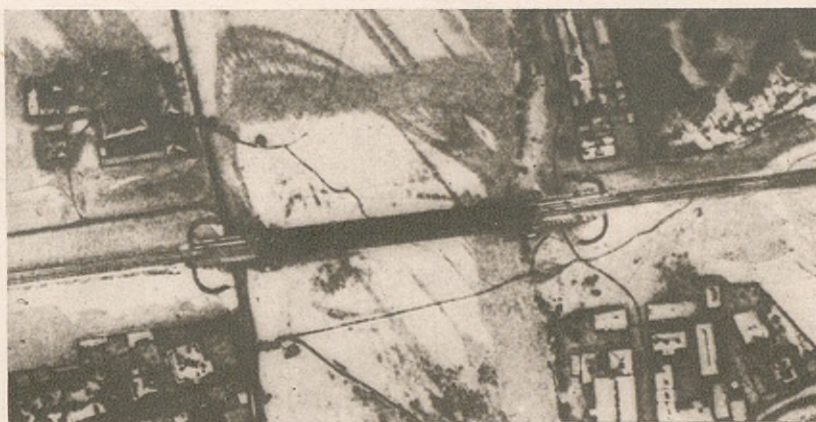
Fot. Nr. 50. Most kolejowy dwutorowy. Rozpoznanie konstrukcji możliwe dzięki cieniowi na zamrożonej rzece.
