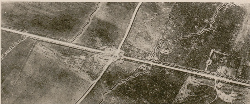
Fot. Nr. 127. Zniszczone skrzyżowanie dróg. Okopy wzdłuż drogi.
