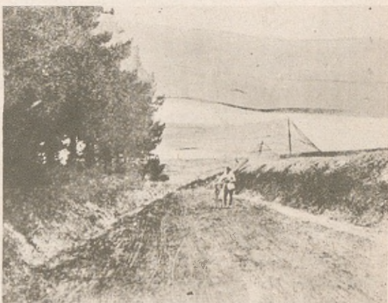
Fot. Nr. 60. Zastłony płócienny nad szosą, maskujące ją od obserwacji bocznej.
