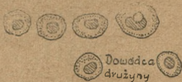
Rys. 7. Pierwsza praca — budowa dołów strzeleckich (wnęków)
