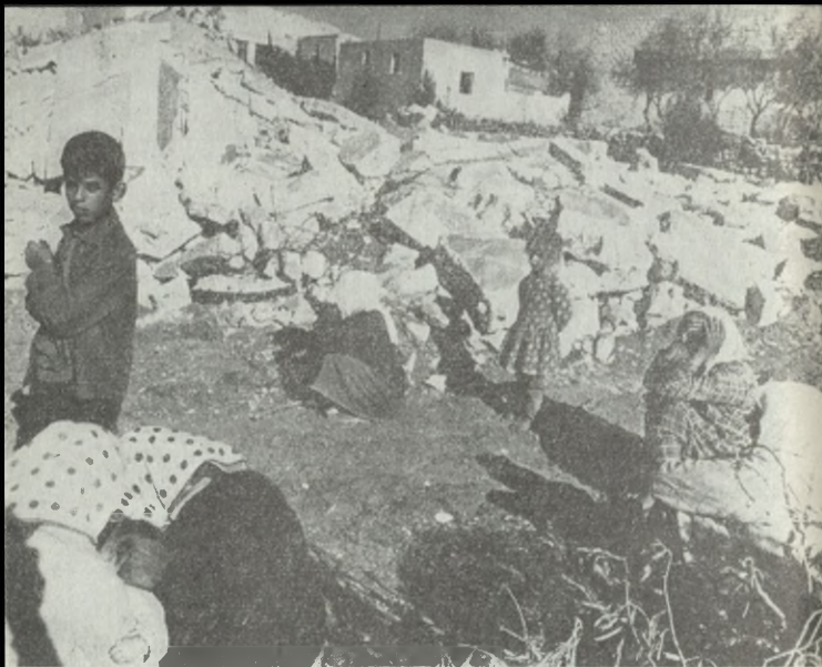
Zniszczone osiedle arabskie
