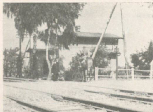
102. Przed dojściem baterji do przejazdu kolejowego zwiadowca informuje się czy o tej porze nie przechodzi pociąg.
