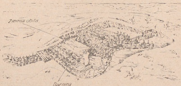
Rys. 142. Stanowisko z ubitej ziemi w czasie budowy
