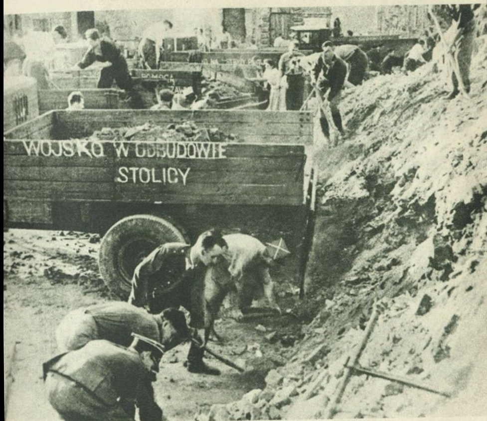
Oficerowie WP przy odbudowie Warszawy
