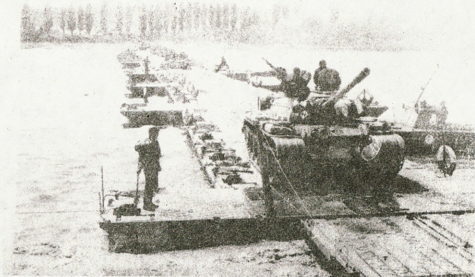
Zdj. nr 3. Blok brzołowy wysunięty za daleko na brzoł.
