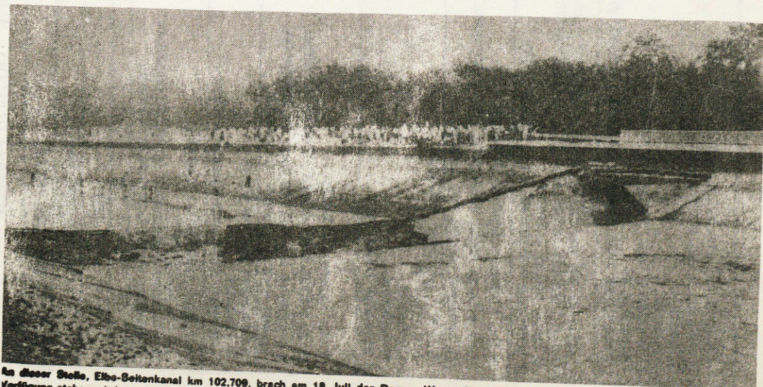
Zdj.nr 15 KANAŁ ELBE - SEITENKANAL PO AWARII W DNIU 18 07 1976r
