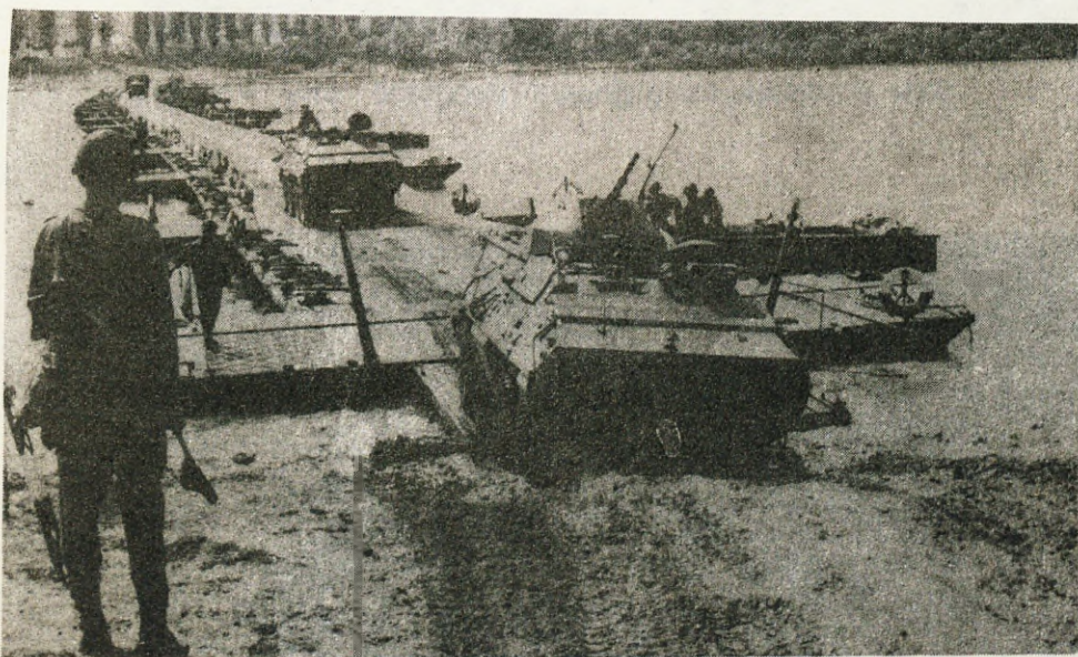
Zdj. nr 2. Stan dojazdu do mostu pontonowego po 1 godz. przeprawy wojsk /przeprawiono 92 pojazdy kołowe i gąsienicowe/ /szybkość marszu na dojeździe 2-3 km/godz./
