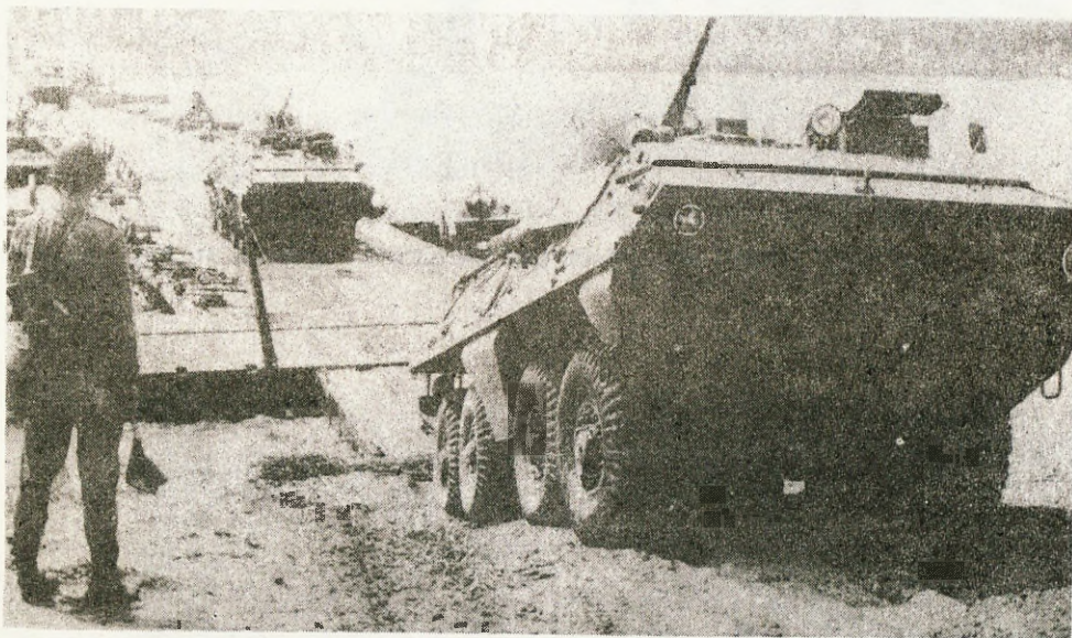
Zdj. nr 1. Stan dojazdu do mostu pontonowego po uruchomieniu przeprawy. /szybkość marszu 10-12 km/godz/
