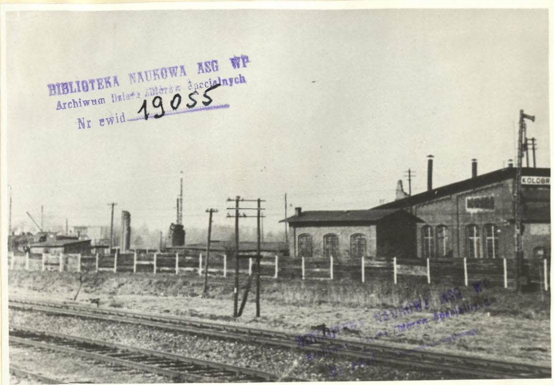
6. Koźobrzeg - parowozownia /obiekt ataków 10 pp/
