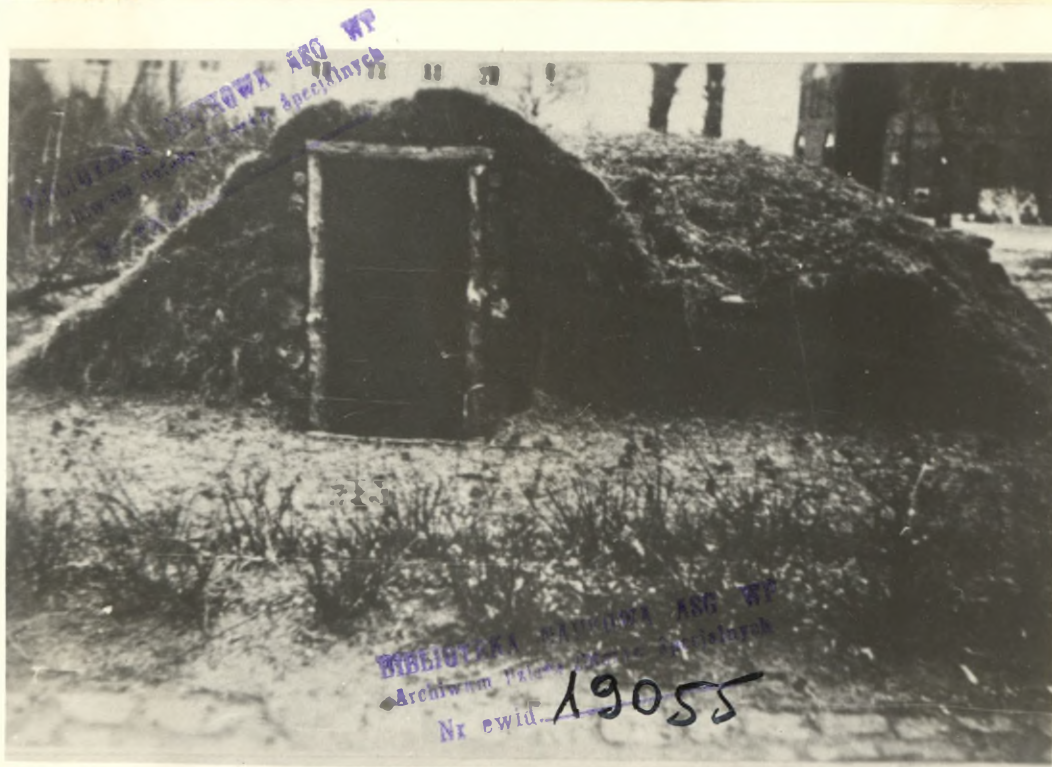
16. Schron - widok z tyłu /wejście/
