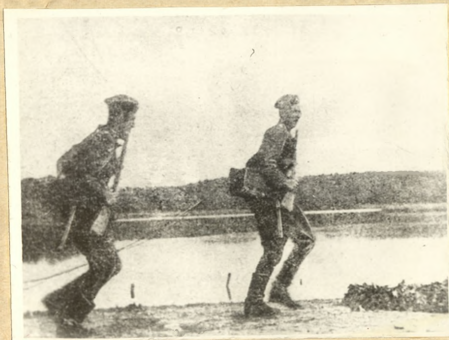
Praktyczne zajęcia z budowy linii.
