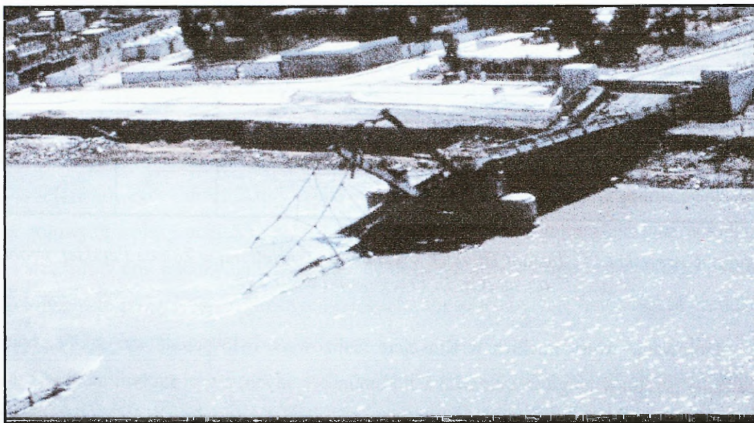
Rys. 5.7. Zniszczony przez lotnictwo most drogowy na drodze Bagdad-Basra.
