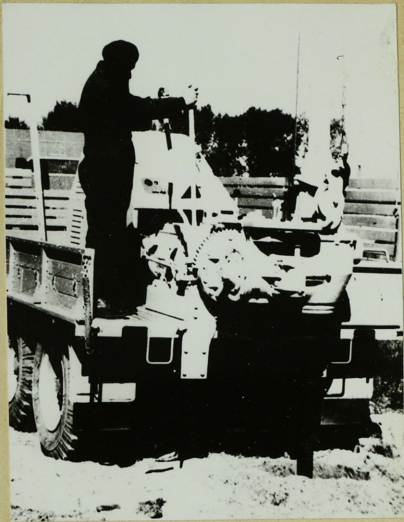
Fot. 3: Wiercenie otworu
