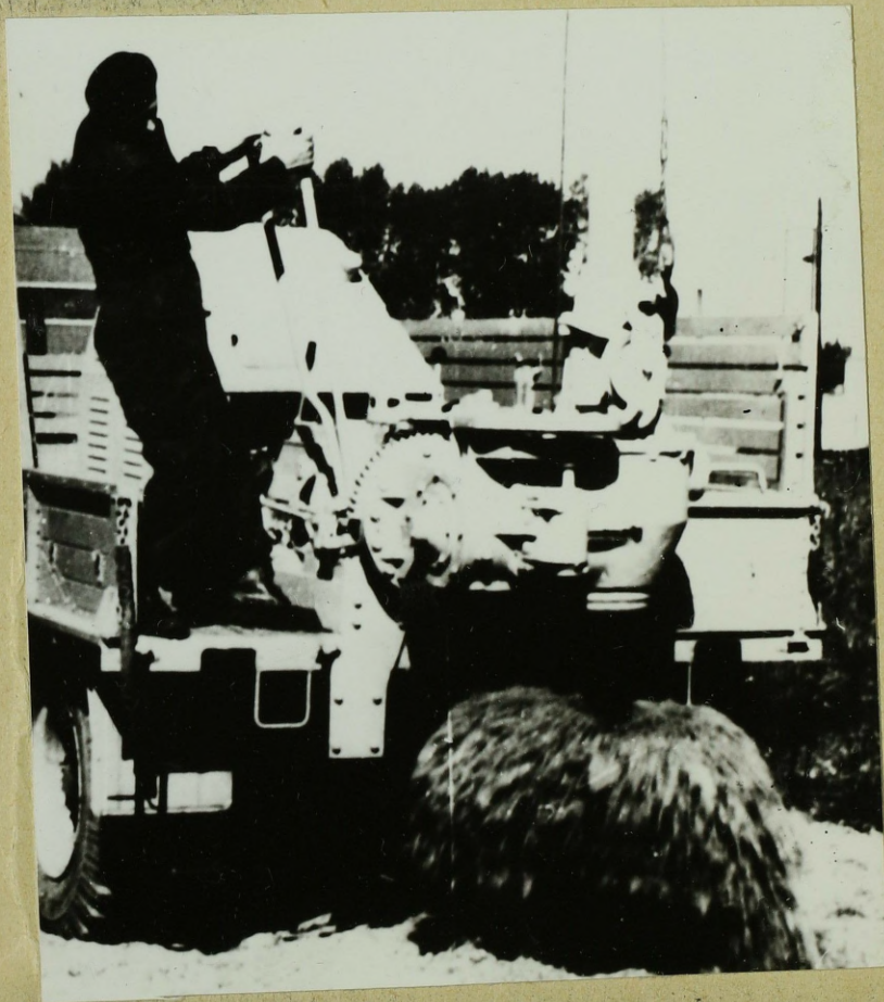
Fot. 4: Wydobywanie ziemi /urobku/ z wierconego otworu
