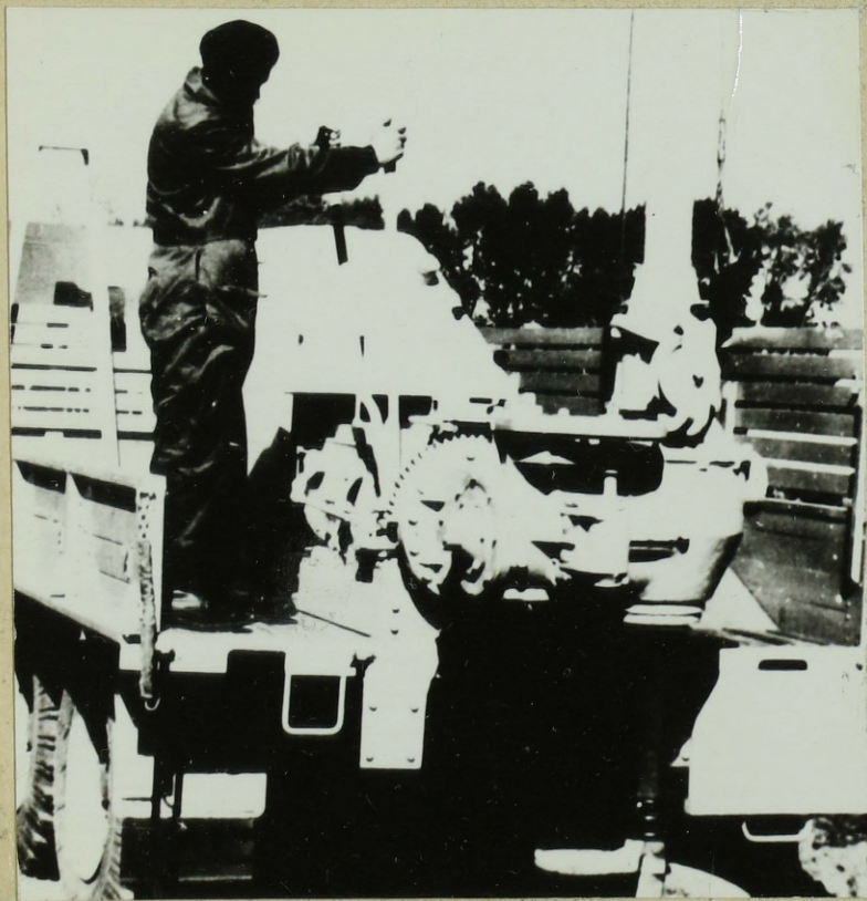
Fot. 2: Przygotowanie urządzenia do pracy, włączenie napędu wiertła
