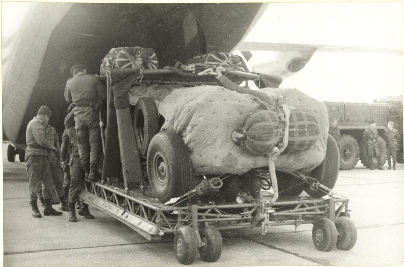
9 PRZYGOTOWANIE PLATFORMY P-127 DO ZAŁADOWANIA DO SAMOLOTU I ZRZUTU
