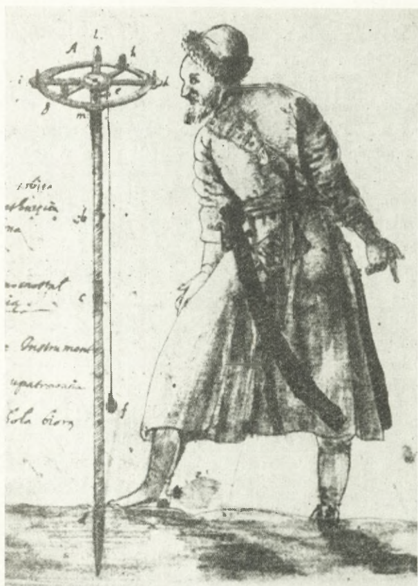
Ryc. 46. Polski inżynier wojskowy XVII w. prowadzący pomiary za pomocą przyrządu zwanego astrolabium. Naronowicz-Naroński, Geometria (BJ, rkps 1452), s. 148.
