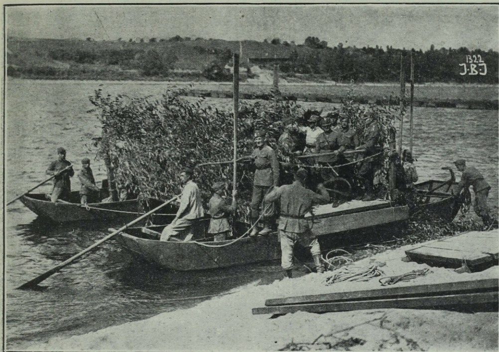
Fot. D 2 . Lekki człon przewozowy na 60 ludzi odbija od brzegu. Przewozi konie. Zamiast przystani pomost ruchomy (leży na brzegu).
