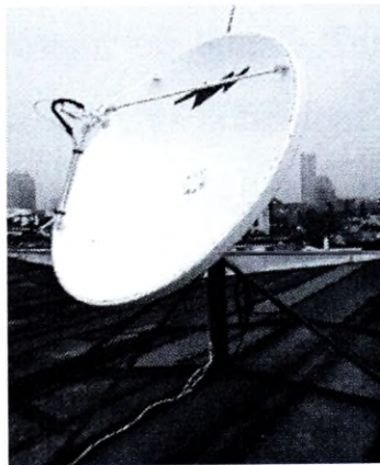
Zdjęcie 2.15. Widok anteny VSAT Satlynx SCPC
