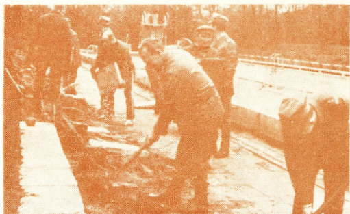
Rozbudowa bazy socjalno-bytowej uczelni w ramach „Czynu Partyjnego” — 1980 rok //// // // // // // // //
