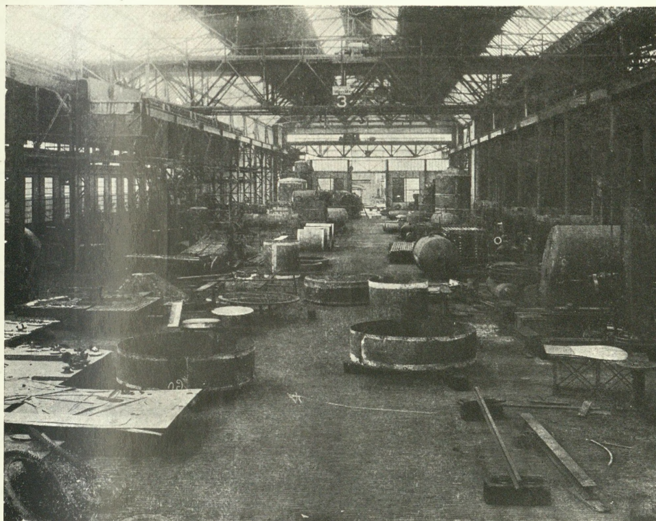
Kotłarnia w Stoczni Gdańskiej.
