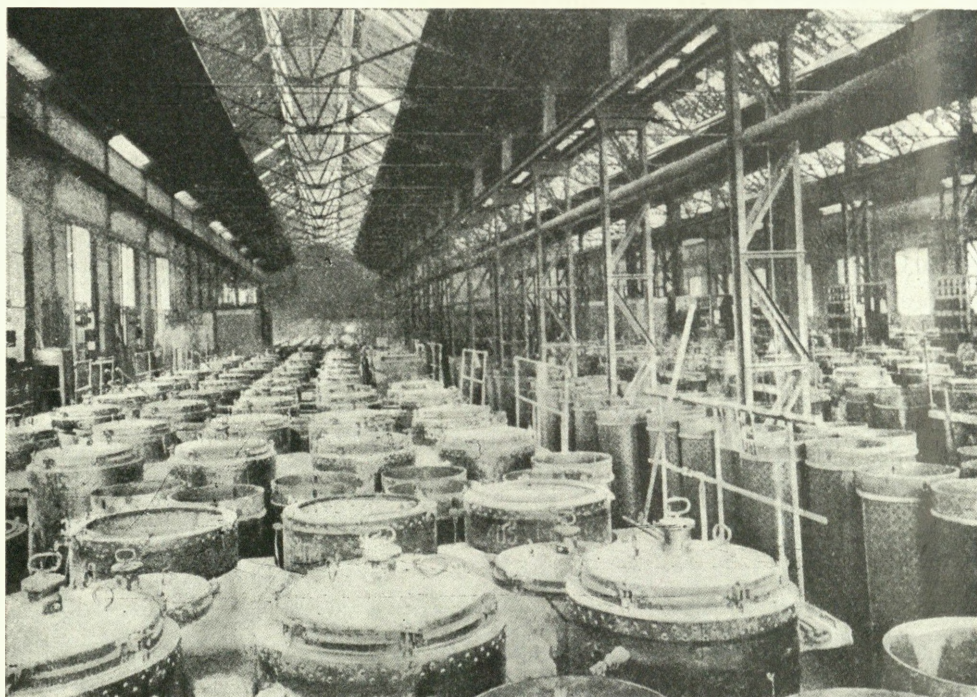
Sala azotniakowa w Chorzowie.
