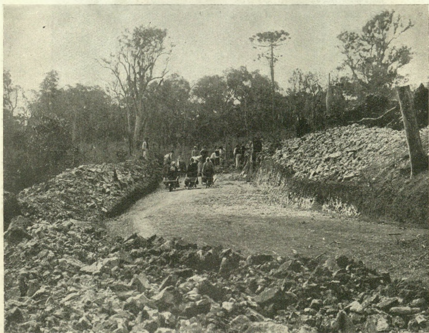
Kolonistki przy budowie drogi na kolonji.
