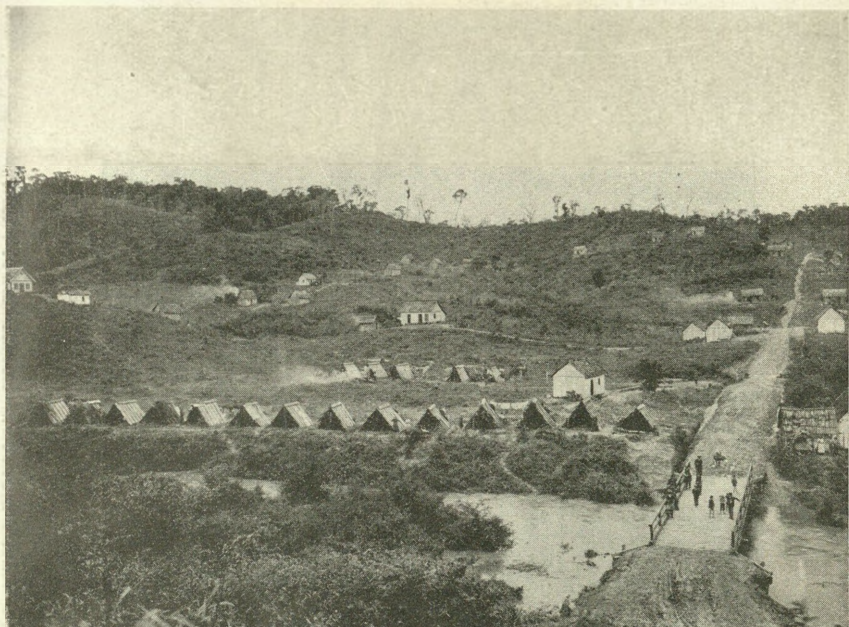
Tymczasowe baraki dla nowych osadników na kolonji Senador Correia.
