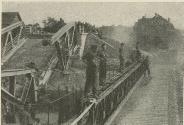
Przeprawa pod Abbeville The crossing near Abbeville
