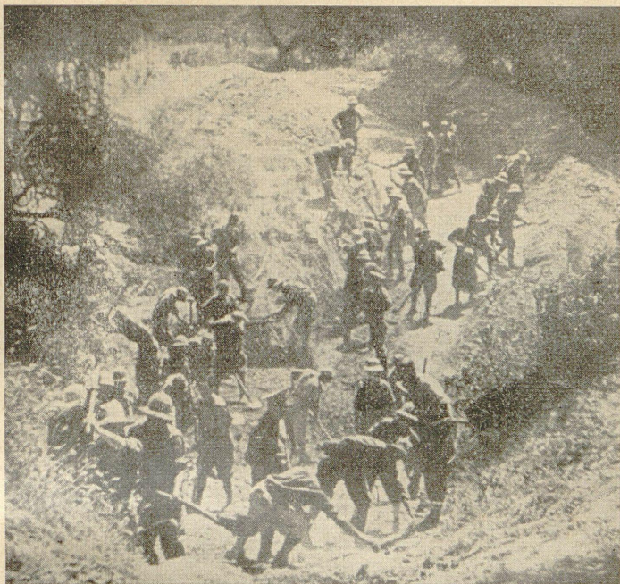
Robotnicy włoscy pracują przy budowie dróg w Afryce Wschodniej
