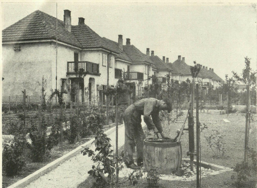
Häuser der Siedlung „Freihof“. Wien, 21. Bezirk
