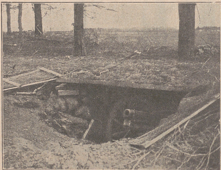
Ryc. 50. Działo przeznaczone do zwalczania czołgów. Maskę osłaniającą dział z przodu (na zdjęciu widoczna na bokach) odrzucano dopiero bezpośrednio przed rozpoczęciem ognia.
