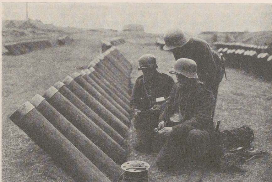
Abb. 5. Deutsche Gaswerfer (18 cm). Leitungstrupps legen Leitungen zu den einzelnen Gaswerfern. Die Gaswerfer (etwa 1000 Stück gleichzeitig) werden von einer Stelle aus mittels elektrischer Zündung zum Abfeuern ihrer Wurfminen gebracht. (Vom Reichsarchiv zur Verfügung gestellt)
