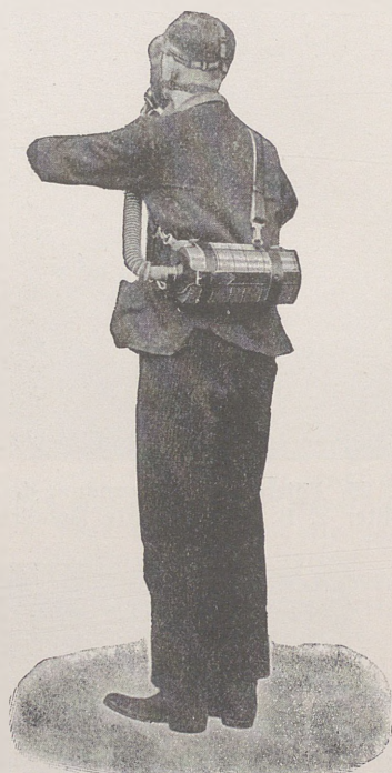
Abb. 28. Filtereinsätze. Degea-Universal-CO-Filter Nr. 86. Das Gerät in Querlage am Hüftkreuz. (Auergesellschaft, Berlin)
