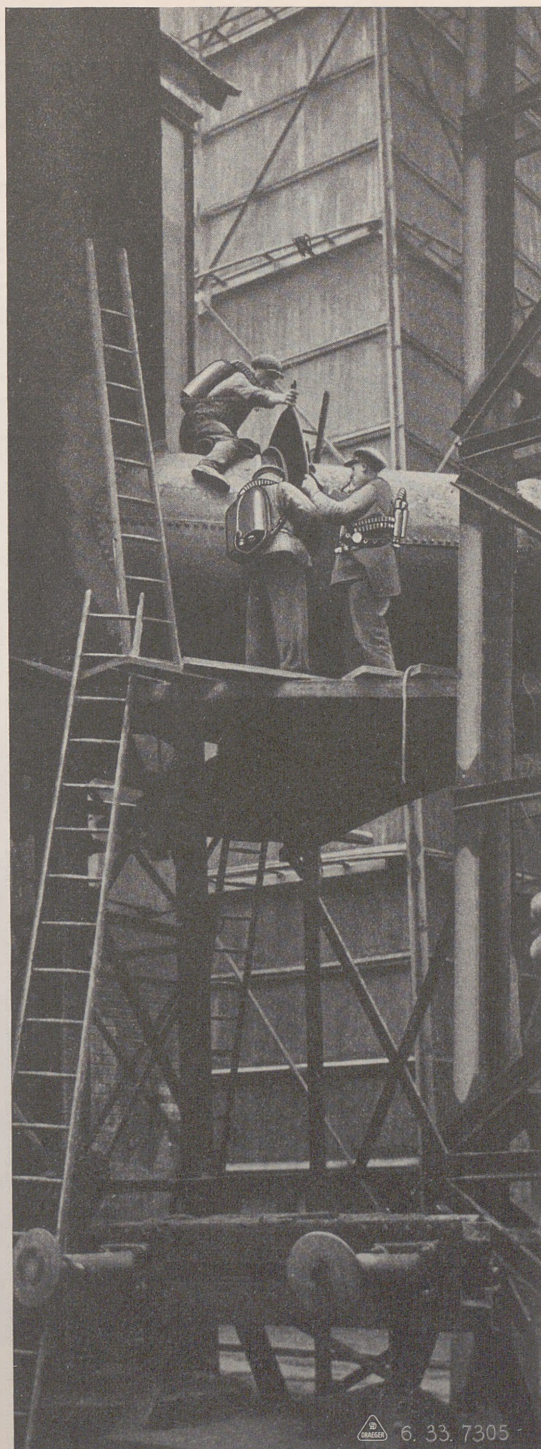
Abb. 13. Die Anwendung von Sauerstoffgeräten. Eine Steckscheibe wird aus einer Gichtgasleitung gezogen. Gichtgas aus Hochöfen enthält bis 30% Kohlenoxyd, außerdem Kohlendioxyd, Stickstoff und Wasserstoff. Wegen der Gefahr des Ausströmens hoher Gaskonzentrationen beim Arbeiten direkt an der Leitung werden Sauerstoffgeräte benutzt. Denn durch diese hohen Giftkonzentrationen würden die gewöhnlichen Gasmasken (Filtergeräte) bald erschöpft sein, wodurch die Arbeiter in größte Lebensgefahr kämen. (Drägerwerk, Lübeck)
