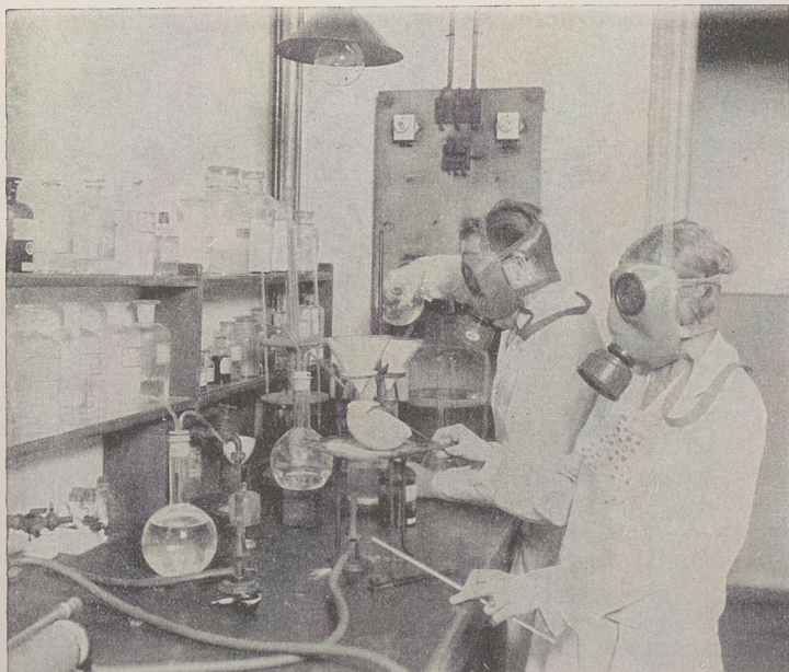
Abb. 26. Filtergeräte. Bei vielen Arbeiten in chemischen Laboratorien müssen wegen der Gefahr des Ausströmens giftiger Gase und Dämpfe Gasmasken getragen werden. Degea A.-G. (Auergesellschaft) Berlin
