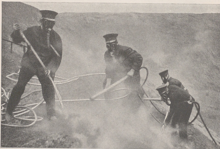
Abb. 19. Schlauchgeräte. Die Arbeiter, die auf einer schwelenden Berghalde arbeiten, sind zu ihrem Schutz mit Injektor-Schlauchgeräten ausgerüstet. (Drägerwerk, Lübeck)
