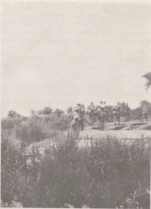
Maszynki śpieszą na linię przez zniszczony most.
