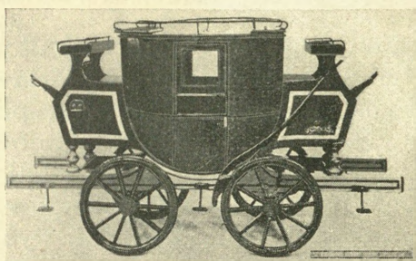
JEDEN Z PIERWSZYCH WAGONÓW KOLEJOWYCH UŻYWANY NA ANGIELSKICH KOLEJACH — BUDOWA SWOJA NIE ODBIEGA OD POCZTOWEGO DYLIŻANSU
