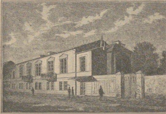
Dom przy ul. Mokotowskiej w Warszawie, gdzie do r. 1863 mieszkał J. I. Kraszewski (później dom D-ra T. Chałubińskiego).
