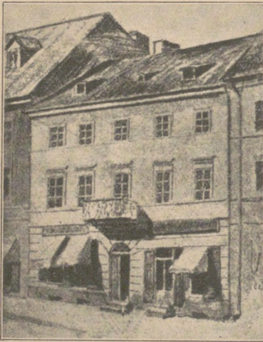
Dom Lelewela przy ulicy Długiej.
