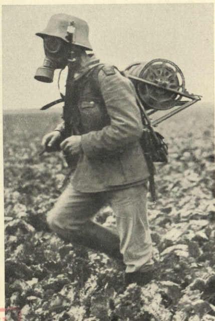
Bild 20. Deutscher Nachrichtenmann beim Verlegen einer Fernsprechleitung.
