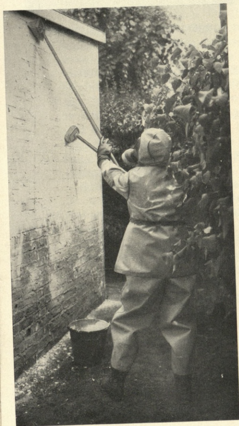
Bild 17. Entgiften einer Mauer mit Chlorkalkbrei.
