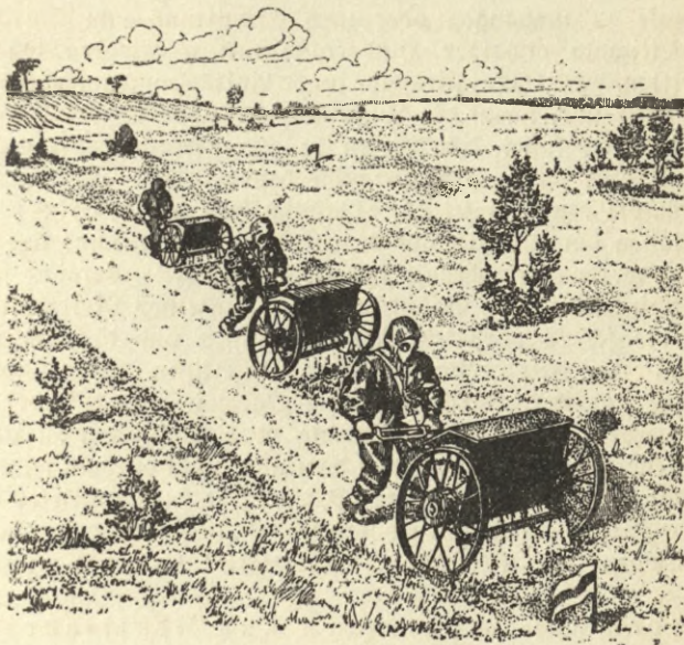
Skizze 20. Entgiften eines etwa 2\frac{1}{2} m breiten Durchgangs durch einen vergifteten Abschnitt. Im Vordergrund eine Flagge zur Bezeichnung der Grenze des vergifteten Raumes.
