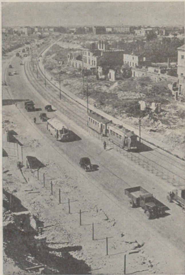
DRUGĄ OBOK TRASY W — Z WIELKĄ INWESTYCJĄ SFOS JEST PRZEBUDOWA UL. MARSZAŁKOWSKIEJ. WIDOK PÓLNOCNego ODCINKA NOWEJ MARSZAŁKÓWSKIEJ.
